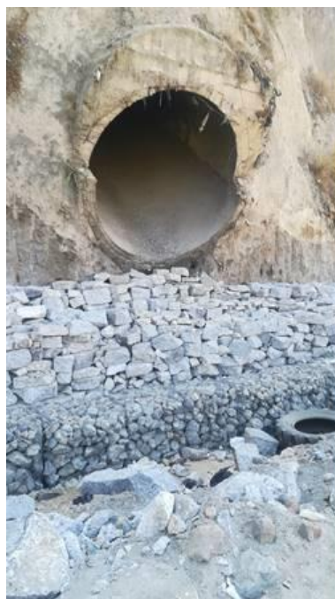
Foto No.1 Protección en 2019 de la base de la descarga
